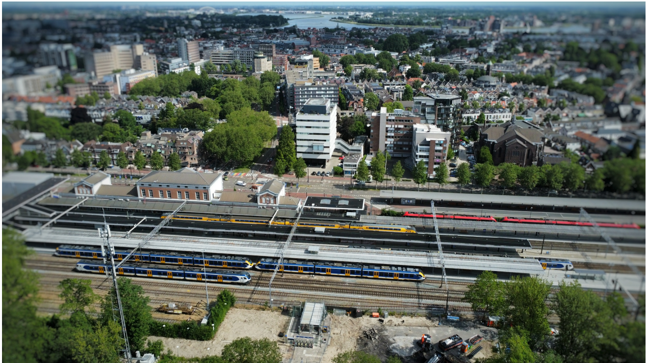
Nieuwbouw fietsenstalling Dordrecht Krispijnzijde
