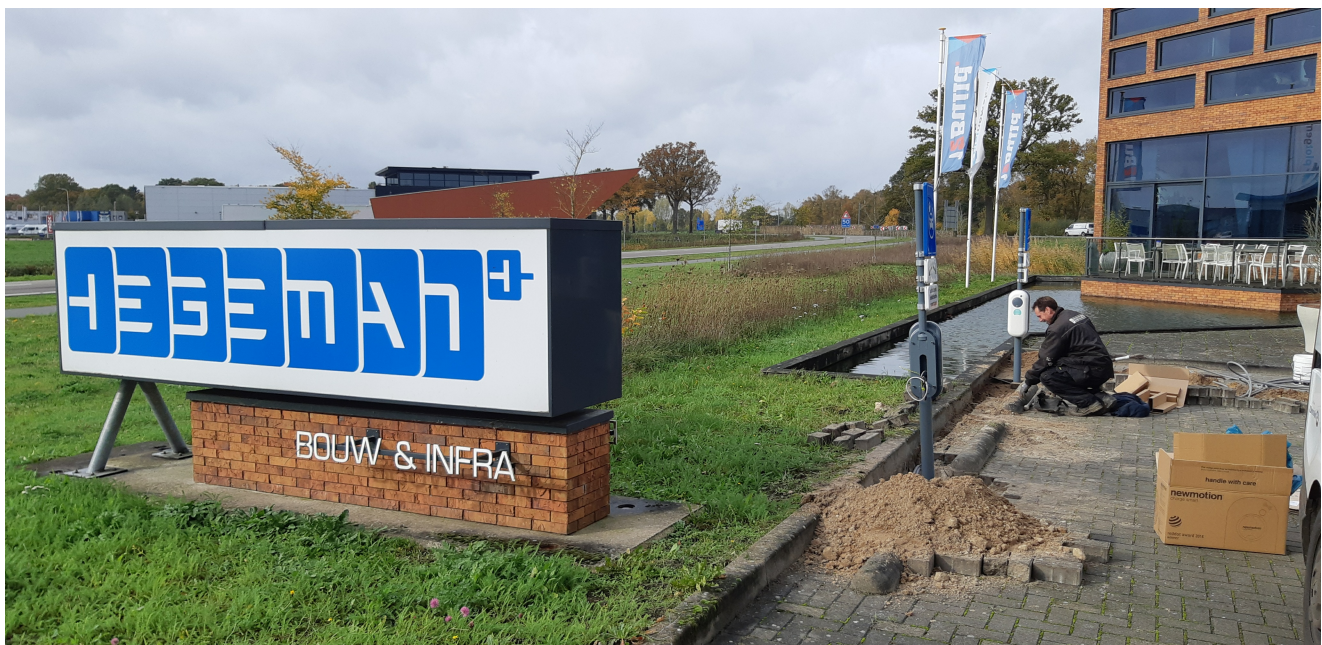
Afbeelding aanleg elektrische laadpalen
