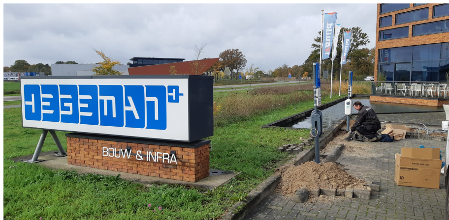
Afbeelding aanleg elektrische laadpalen
