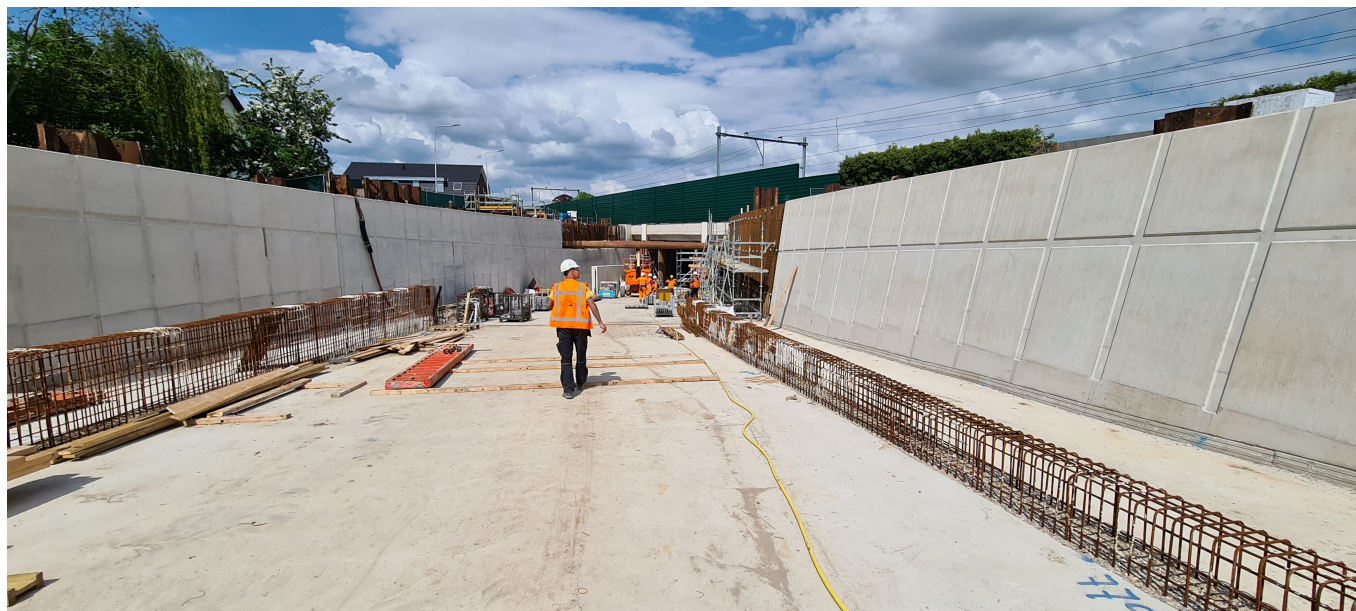
Afbeelding onderdoorgang Rijksweg Noord te Elst
