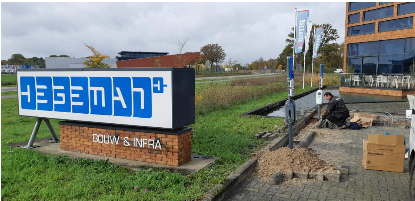
Afbeelding aanleg elektrische laadpalen
