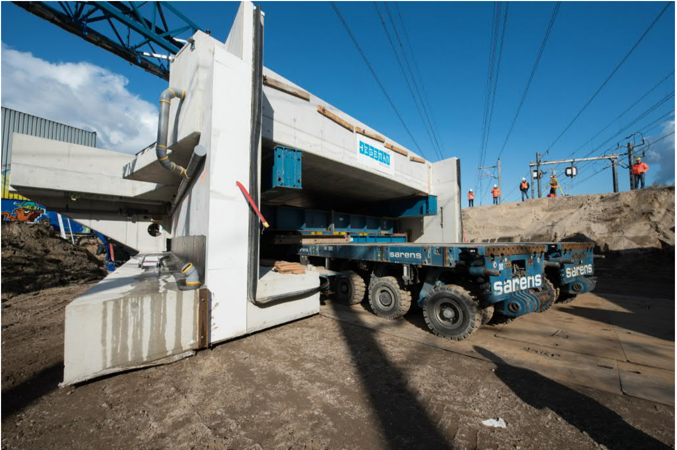
Het inrijden van het kunstwerk voor de onderdoorgang Locomotiefstraat te Utrecht
