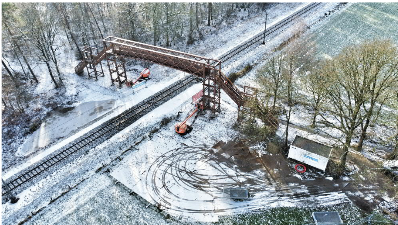
Afbeelding aanleg houten spoortrap te Vilsteren
